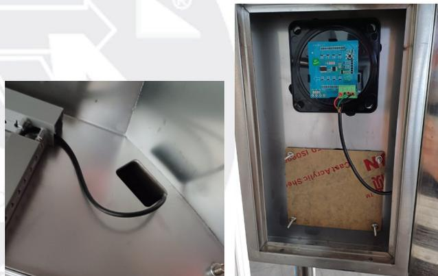
9) Fissare i lettori RFID, se richiesti, utilizzando le staffe in dotazione. Passare il cavo dei lettori attraverso lo stesso montante da cui scende il cavo per l'indicatore luminoso.
